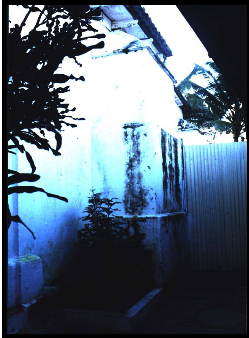
CONTRAFUERTE UBICADO A LA ALTURA DEL ARCO TORAL , ESTE SE LOCALIZA EN LA FACHADA NORTE DEL INMUEBLE
